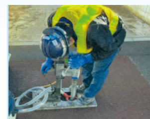
▲路面下空洞調査の様子
