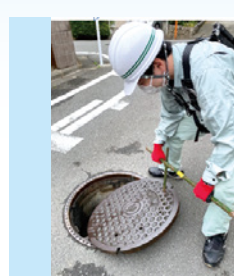
◀マンホール定期点検の様子
