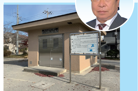
▲明神下公園内にある応急給水施設
