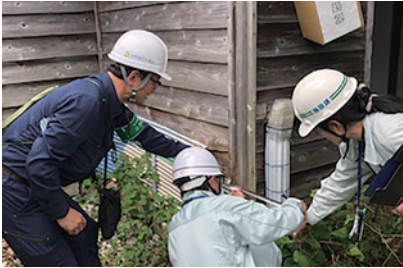
▲被災建築物応急危険度判定実地訓練の様子
