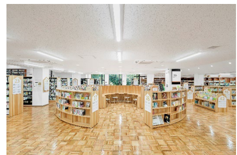
研削・下地調整・日除り後の「読書フロア-リングブロック」
