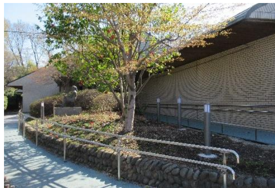
駐車場からの通路の整備
