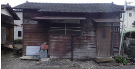
▲除却前の空き家
