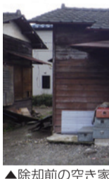
▲除却前の空き家
