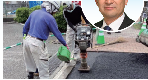
▲道路補修作業の様子
