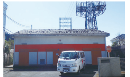
▲わらつけ中央災害備蓄庫
