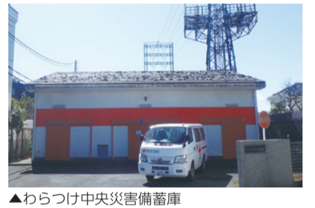
▲わらつけ中央災害備蓄庫
