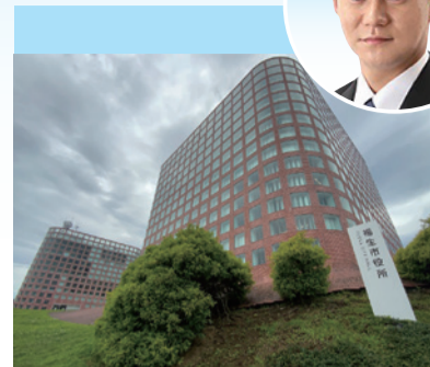
▲福生市役所外観
