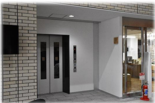
▲エレベーターの新設等バリアフリーの整備
