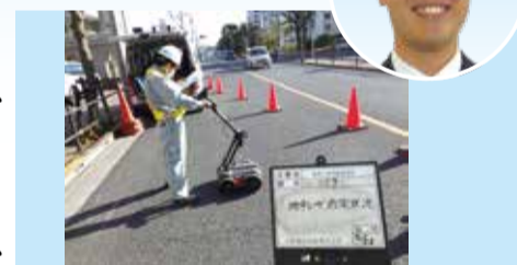
▲道路ストック点検の様子
