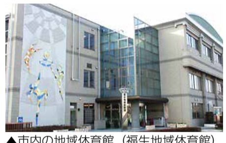
▲市内の地域体育館（福生地域体育館）
