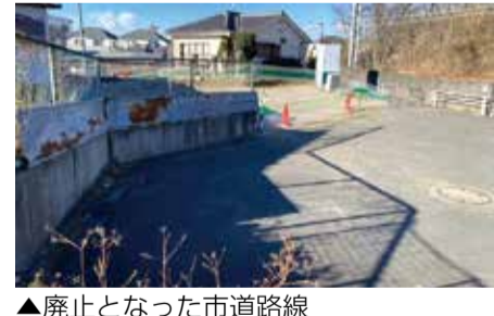
▲廃止となった市道路線
