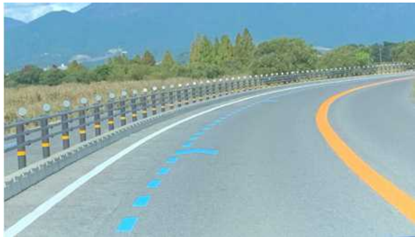
▲自転車走行部分の路面標示
