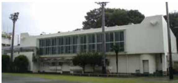
▲空調設備を更新した福生第三中学校講堂
