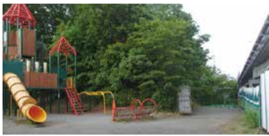
▲改修工事を実施する日光橋公園
