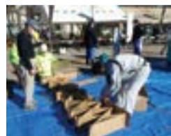
▲ベットの組み立ての様子
