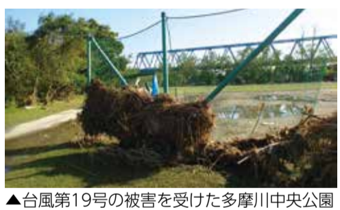
▲台風第19号の被害を受けた多摩川中央公園
