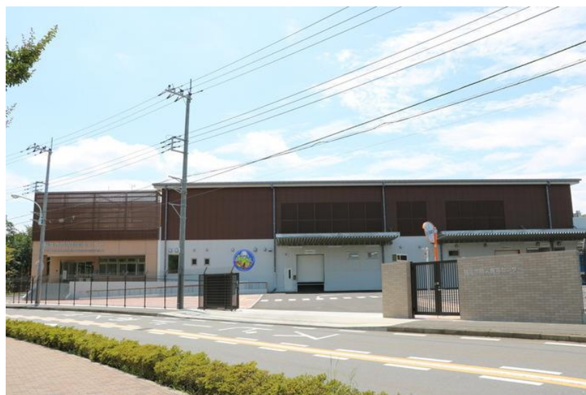
写真 平成29年に供用開始した防災食育センター
