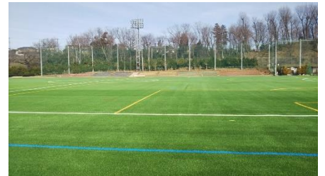
人工芝敷設工事中の市営競技場
