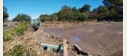
【被害状況】全体浸水
