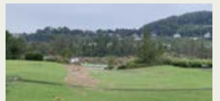
【被害状況】一部浸水
