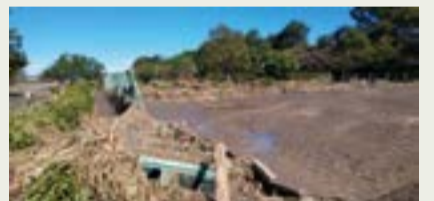
【被害状況】全体浸水
