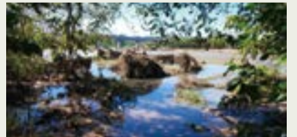
【被害状況】一部浸水
