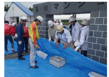
都市型水防工法の様子
