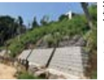
▲防護した法面
