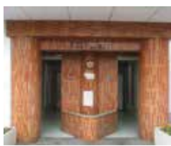
▲福生駅東口公衆便所
