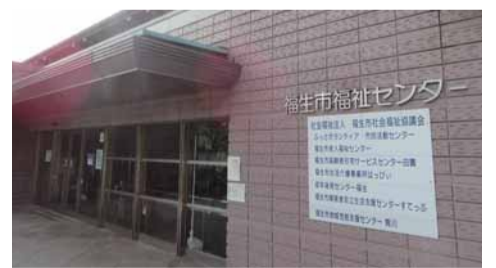
▲設備改良工事が予定されている福祉センター
