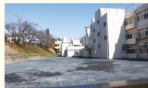
▲第三小学校の給食センター跡地
