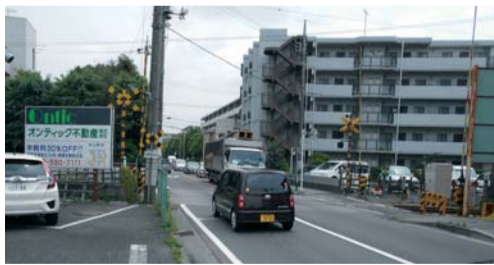
▲信号機設置予定の五日市街道砂川街道踏切
