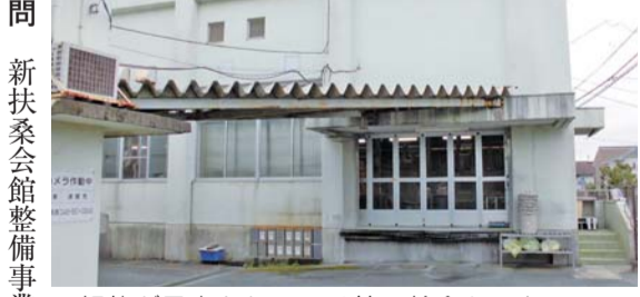
▲解体が予定されている第一給食センター
