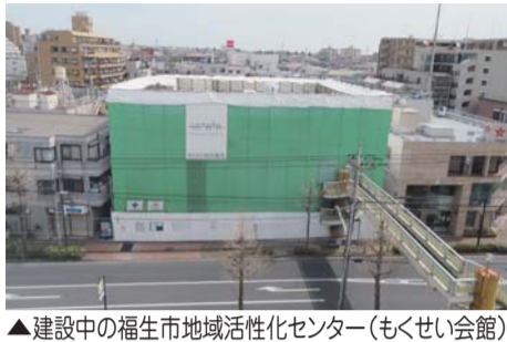
▲建設中の福生市地域活性化センター（もくせい会館）
