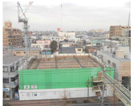
▲平成29年度完成に向け工事が進むもくせい会館
