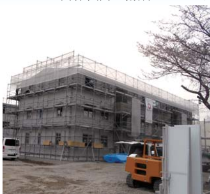
▲自由広場工事現場（福生 2131 番地 1）
