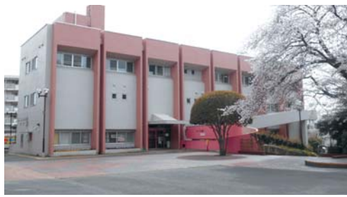
▲さくら会館外観の様子
