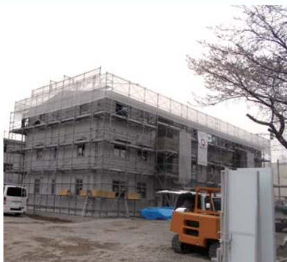
▲自由広場工事現場（福生 2131 番地 1）
