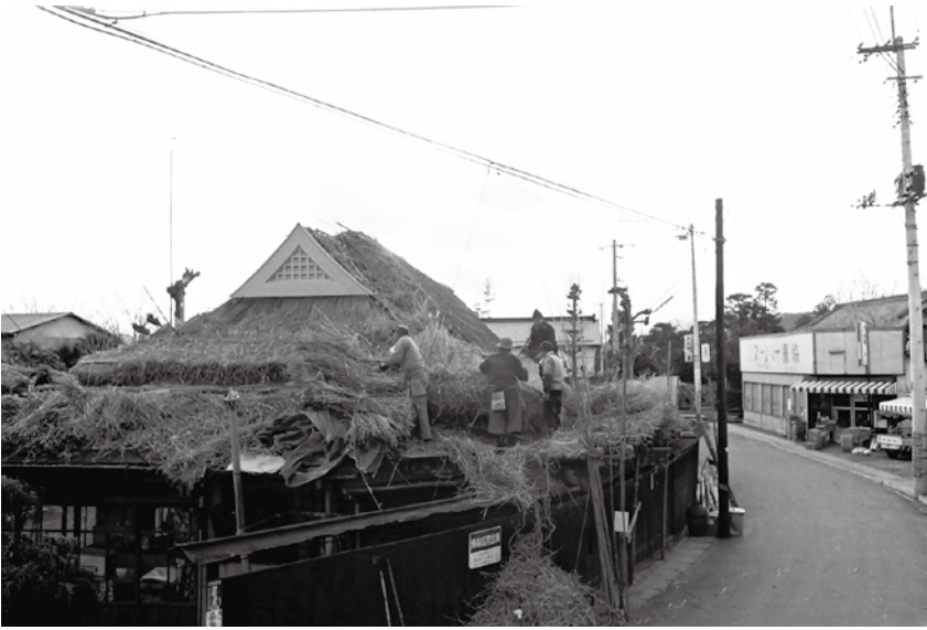
①/昭和50年に撮影された宿橋通り沿いの民家。萱葺き屋根の張替えをする様子が当時の郷愁を誘う。写真提供：福生市郷土資料室
