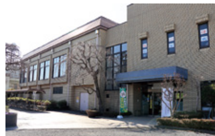
熊川地域体育館
