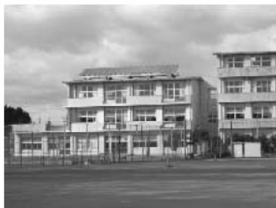
学校屋上の太陽光パネル例
