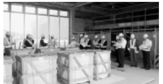
▲拝島駅自由通路工事を視察
