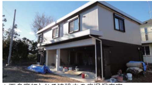
▲西多摩初となる建設中の病児保育室
