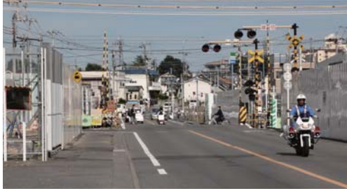
▲都で行う都道整備工事(志茂地区)
