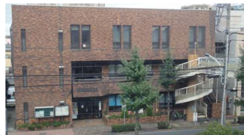
▲建て替えが予定されるもくせい会館
