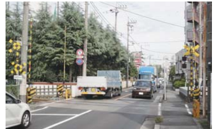
▲信号機設置が望まれる五日市街道の引込線踏切
