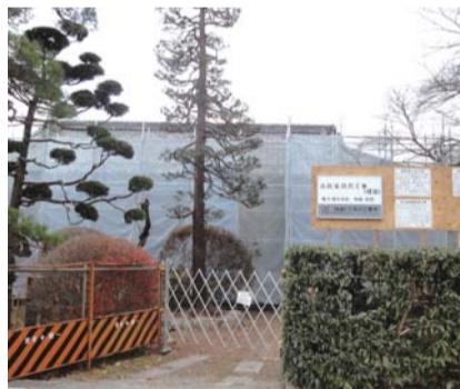
▲改良工事中の旧ヤマジユウ田村家住宅
