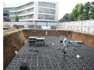
校庭に雨水貯留施設を設置
