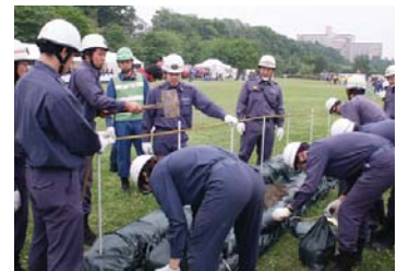
積土のう工法
