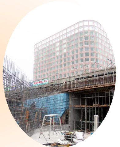
建設中の新庁舎
