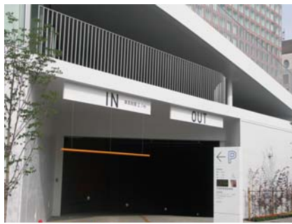
庁舎地下駐車場入口
